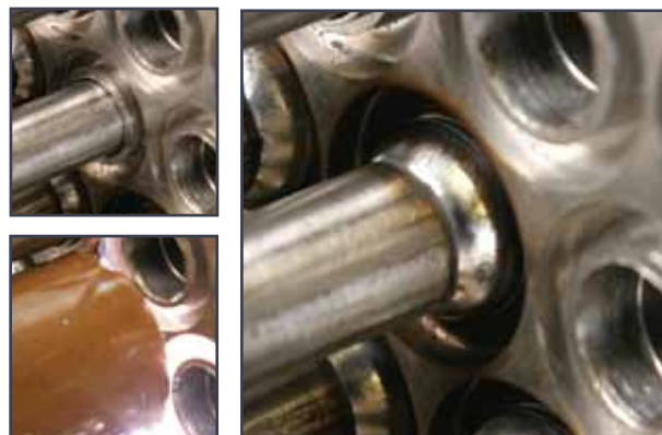
Приваривание элемента к трубной решетке орбитальным методом
